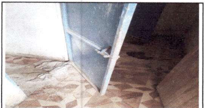
Foto 6: Reparación de Piso de granito
